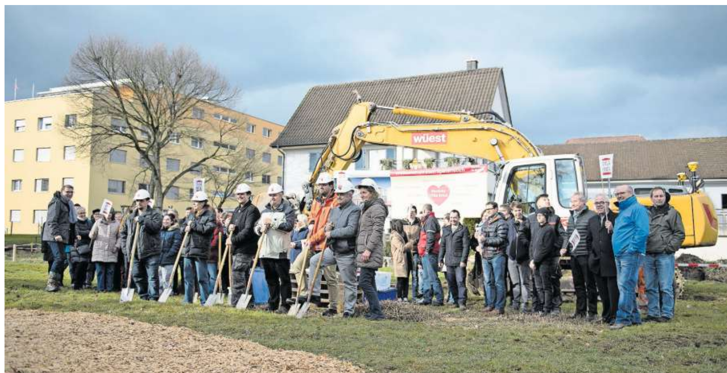
Erster Schritt: Der Spatenstich für den Neubau erfolgte am Freitag.
