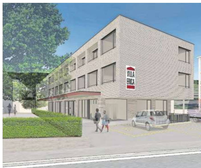
So soll der Neubau Villa Erica dereinst aussehen.
