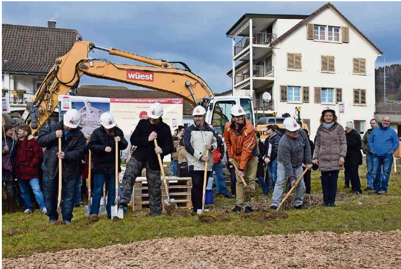
Gestern fand der Spatenstich für den Neubau der Stiftung Villa Erica an der Bahnhofstrasse in Nebikon statt.
