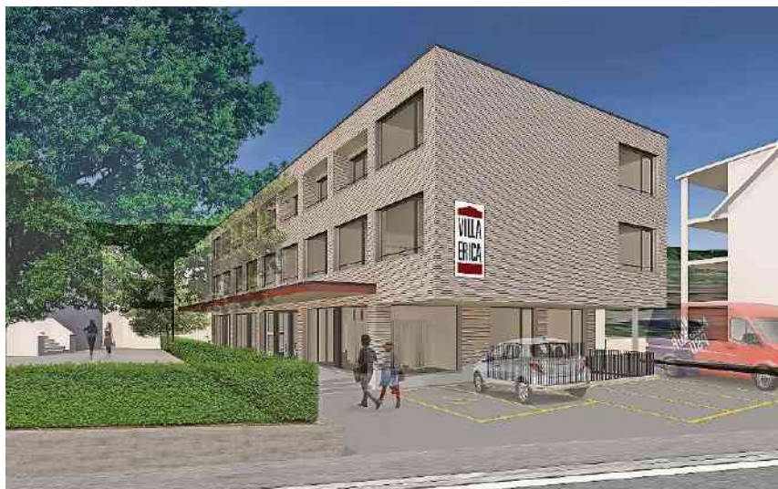
Im Frühling 2019 soll der Neubau bezugsbereit sein.
